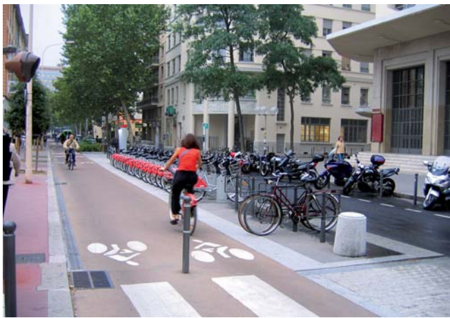
Piste intercalée entre le trottoir et le stationnement
