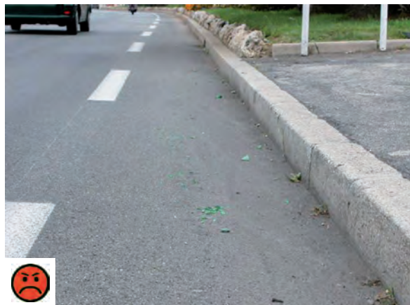
Mauvais entretien rendant la bande impraticable
