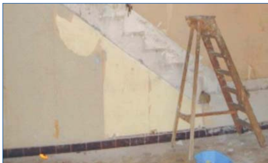
Pendant les travaux - Source : habitante de l'immeuble
